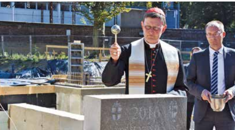
Kardinal Woelki legt den Grundstein für den Neubau des Willkommenszentrums im Klarissenkloster.
