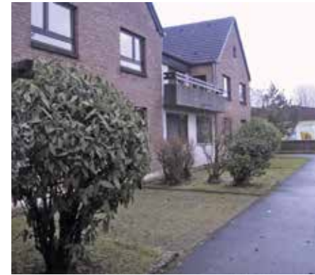
Bestand vor Abriss, Caritas-Altenzentrum Elisabeth-von-Thüringen-Haus in Köln-Worringen
