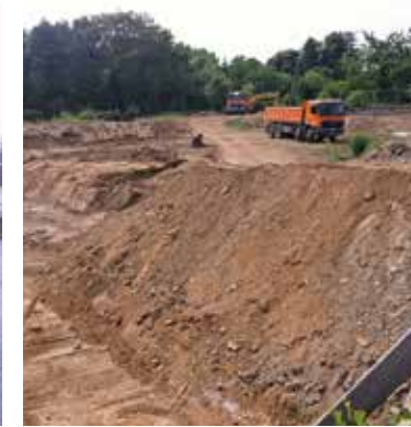
Vorbereitungen für den Neubau
