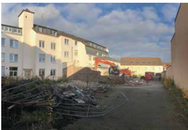
Die Abbrucharbeiten des ehemaligen Altenzentrums St. Josef haben begonnen.
