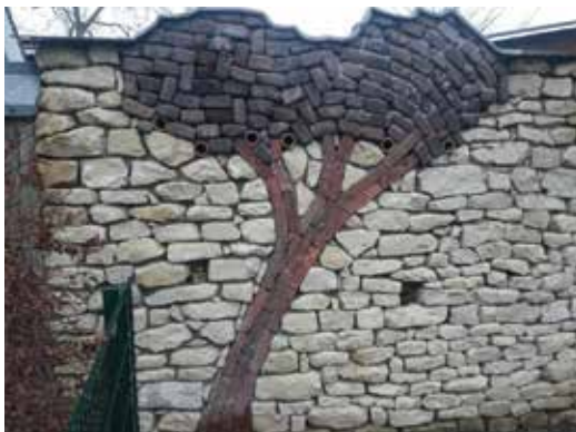
Die Klagemauer im Hospizgarten in Porz
